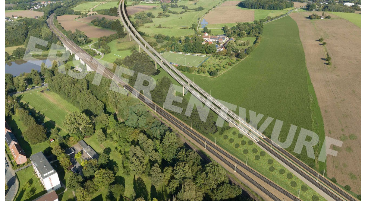
Foto-Montage: Bild nach Umsetzung des Bahn-Projekts. Lage, Art und Dimensionen der Bauwerke werden sich noch ändern.
